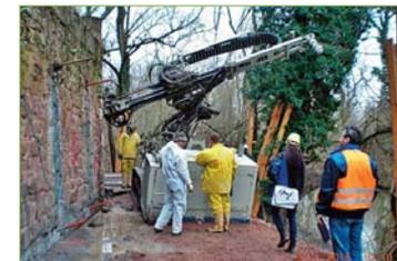
Mit schweren Maschinen werden riesige Verpresspfähler durch die Mauer hindurch in das dahinter liegende Gestein getrieben.
